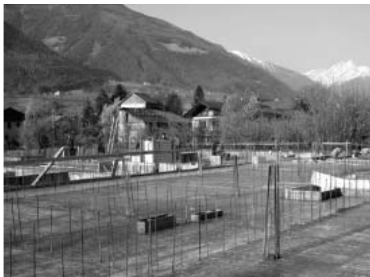
Die erste Decke ist betoniert
