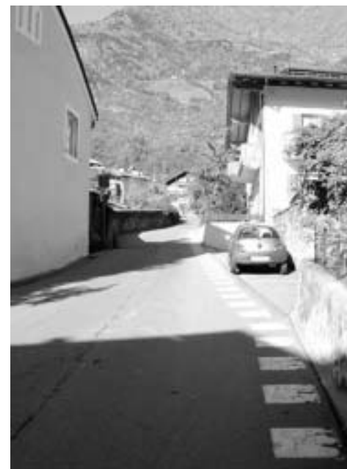
Während den Grabungsarbeiten wird der Schlossweg nur beschränkt befahrbar sein.
