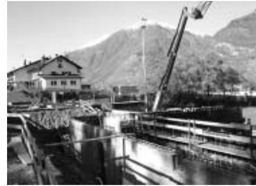
Die Unterkellerung ist im Wesentlichen abgeschlossen.
