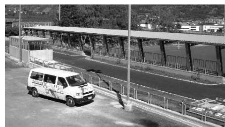
Zwischenzeitlich wird der Asphaltplatz als Parkplatz genützt, im Sommer gehen die Bauarbeiten weiter.
