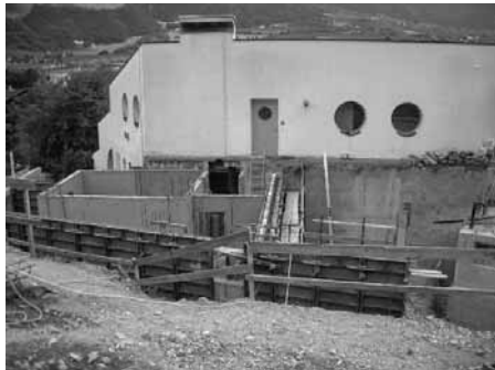
Die Saunaerweiterung ist im vollen Gange.
