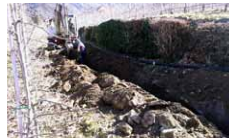
Die Verlegung in der „Stabner Gasse“ konnte zügig durchgeführt werden.
